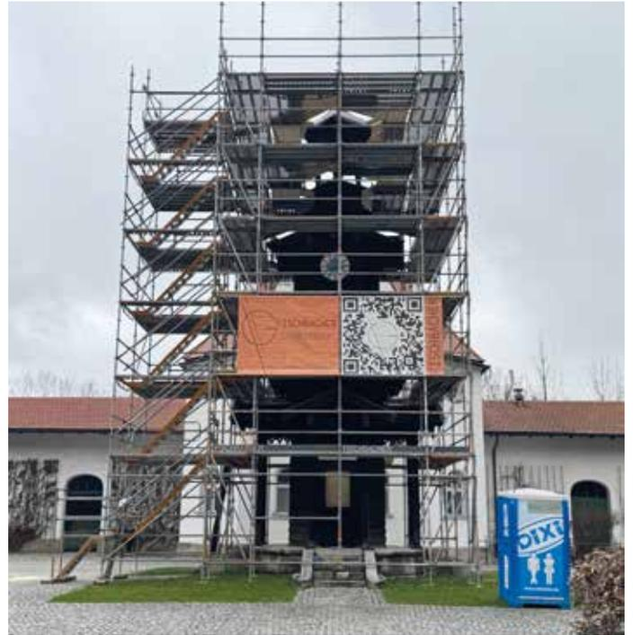
Die witterungsbedingten Schäden am Uhrturm der Festhalle Hohenaschau werden nach Jahrzehnten aktuell denkmalrechtlich ausgebessert und die Konstruktion von den Stützfüßen bis zur Turmkappe instandgesetzt. Eine neue Beleuchtung soll künftig die Konstruktion in den Abendstunden dezent in Szene setzen.
