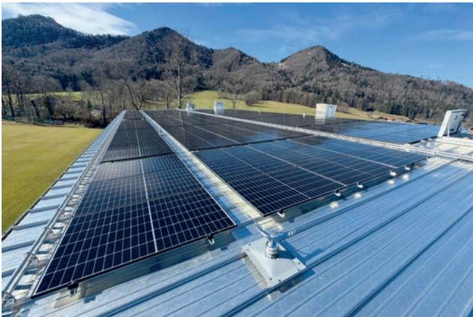
Dieser Tage werden die Module der Photovoltaikanlage auf dem Dach der Priental-Halle montiert. Sie sind ein elementarer Teil des Gesamt-Energiekonzepts und haben zusammen eine Spitzen-Leistung von rund 90 Kilowatt (kWp). Sie werden ergänzt durch einen erweiterbaren Batteriespeicher mit einer Kapazität von ca. 30 kWh.
